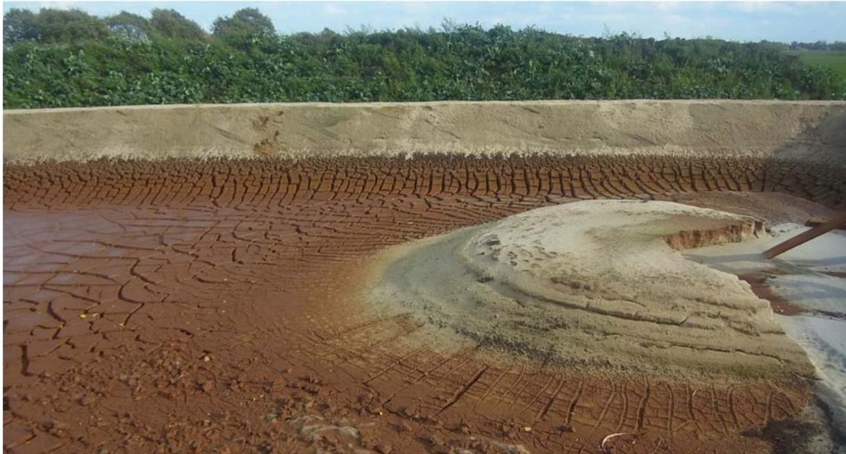
**Bild 48: Natürliche Materialelektion (Sandfang) an der Einspülstelle im Absetzbecken 1 am Lorenzgraben (Foto: Hiekel, 17.10.2013)**
